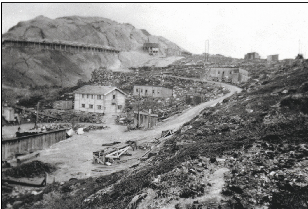
Brakkeleiren ved Raudalsanlegget på slutten av 1940-talet. Foto utlånt frå Skjåk Historielag sitt fotoarkiv/fotograf. L. Skamsar.
