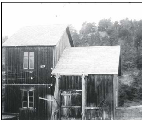
Da Aura kraftverk vart lagt ned, fekk ei rekkje gardar i øvre og nedre Reppen ei avtale, der KL Opplandskraft/Vannkraft Øst forplikta seg til evig å halde ved like å ha tilsyn med vatnarvatnet frå Aura og til vatningsanlegga til alle desse gardane utan at det skal koste dei noko. Dette er ein stor verdi for gardbrukarane i Reppen. Foto utlånt frå Skjåk Historielag sitt fotoarkiv.
