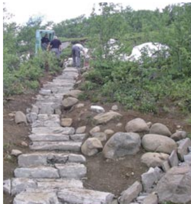
Arbeidet med stigen opp mot Besseggen. Foto: Knut Øyjordet.
