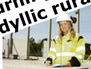
LEDER: Linda Bamberg er prosjektleider for byggingen av utnyttet kantar og verkstedsbygg på Horvane.
