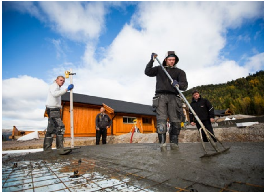
Lokal sysselsetting. Asbjørn Tysland (bak til venstre) og Vegard Fallet (bak til høyre) inspiserer byggingen av en garasje i Solskiva Hyttegrend
