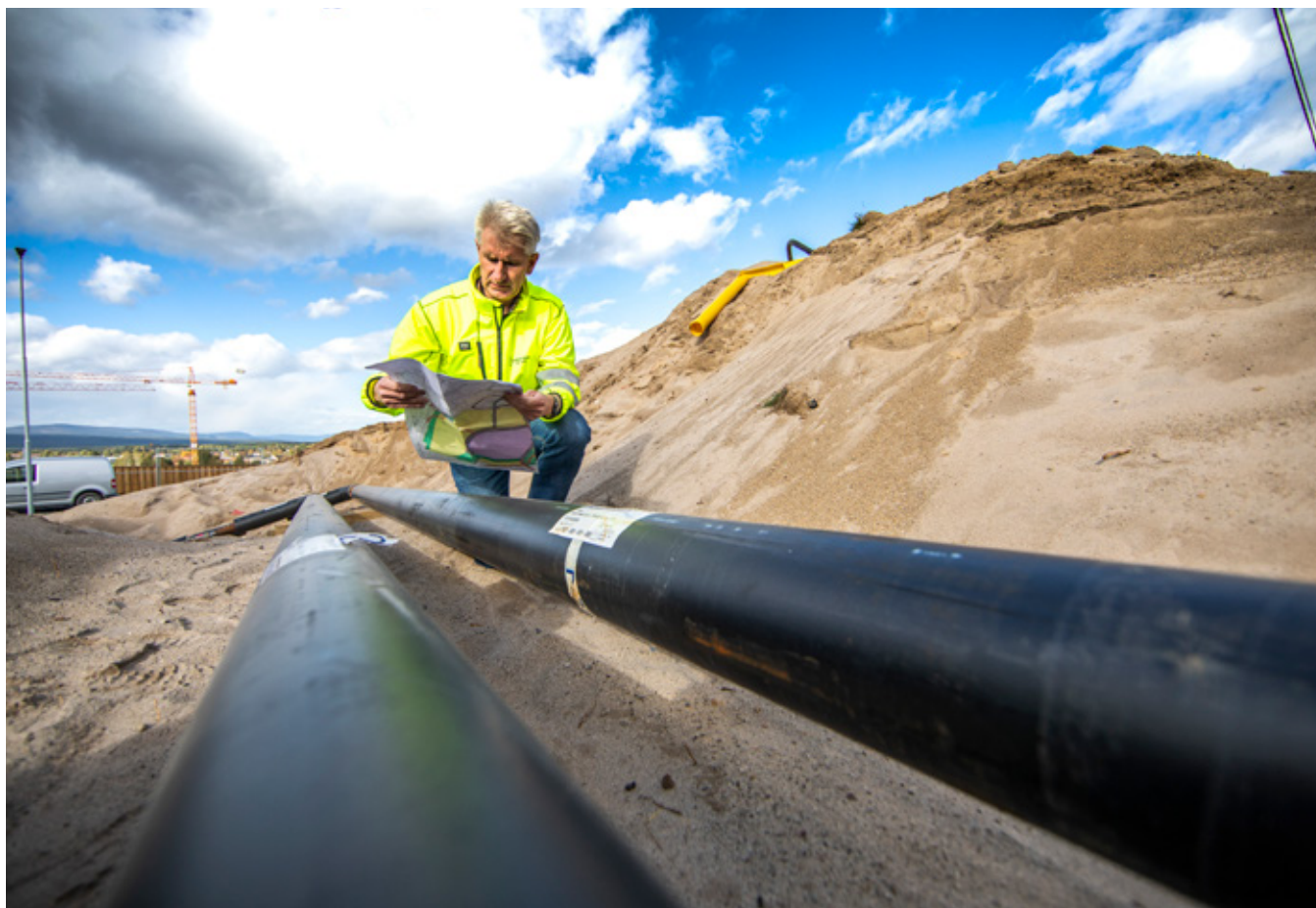
Befaring: Daglig leder Odd Erling Lange i Elverum Tomteselskap sjekker at alt går etter planen på Ydalir-området.
