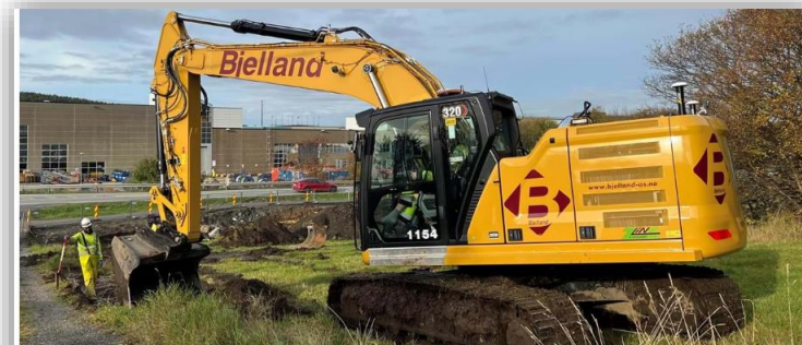
De to elektriske gravemaskinen Bjelland AS har kjøpt inn, er begge satt inn i arbeidet med Transportkorridor Vest langs riksvei 509 Sor-Tjora–Kontinentalvegen på Sola.
